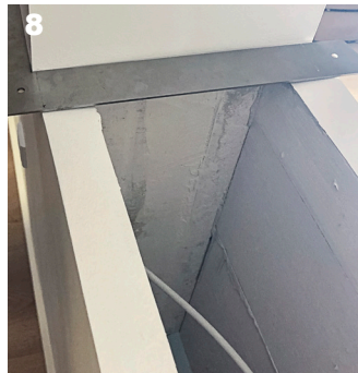
8 De 2 vægge skal være i vatter / The 2 wall must be in level.
