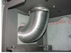
Abb. d. Frischluft Anschluss
